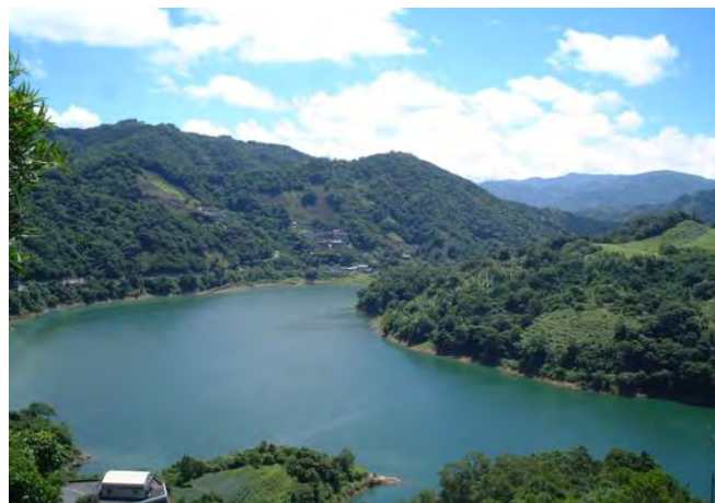
圖 4 新北市石碇區永安里水庫
