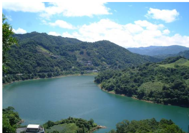
圖 4 新北市石碇區永安里水庫
